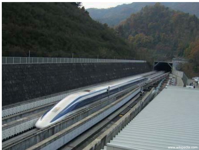
Ligne expérimentale proche de la ville japonaise de Otsuki. La vitesse record de 581 km/h a été atteinte en 2003. L'objectif serait de construire une ligne Tokyo-Osaka, parcourue en une heure.
