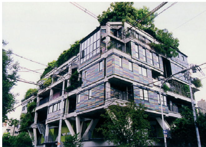
À Osaka, l'immeuble NEXT 21 représente l'exemple le plus abouti d'une architecture industrialisée associée à un urbanisme permutatif.
