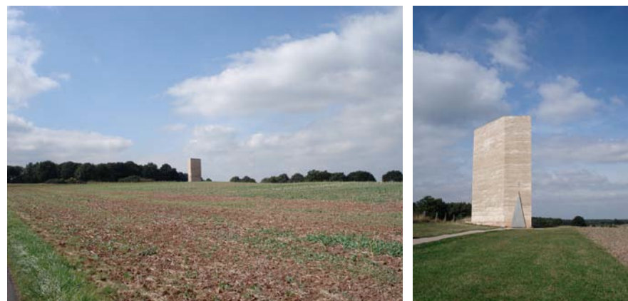
Fig 2 et 3 La chapelle dans son site près du village de Wachendorf. On peut discerner les 24 couches de béton, banché à la manière d'un pisé.
