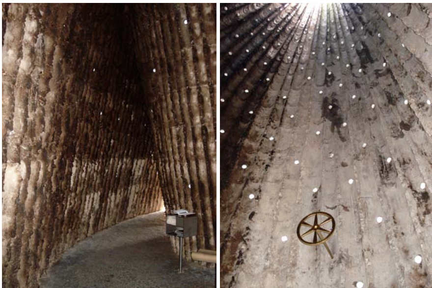
Fig 9 Les demi-billes de verre confèrent un aspect étoilé à la paroi de béton noircie et délavée là où la pluie la nettoie. Remarquer l'anneau doré comportant six secteurs.
