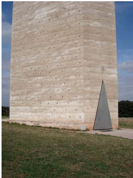
Fig 4 La porte en acier inoxydable triangulaire pivote autour d'un axe vertical et est surmontée par une petite croix, seul signe extérieur de son appartenance à la religion catholique.
